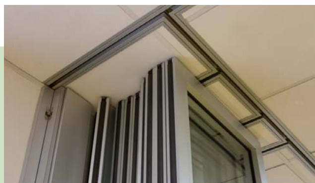
Dettaglio della parete in vetro con veneziana inserita Detail of a glass partition with venetian blind inserted
