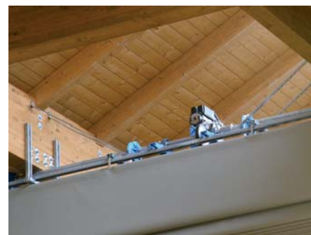
Il sistema motorizzato di sollevamento.
